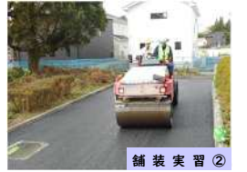
舗装実習②
