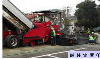
舗装実習①
