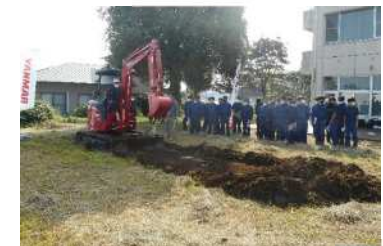
ブレード3Dマシンコントロールバックホウ体験
