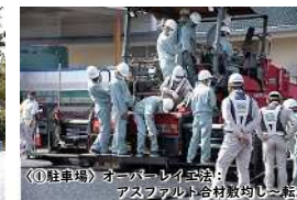
〔1〕駐車場〕オーバーレイ工法： アスファルト合材敷均し～転圧
