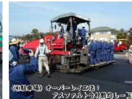
〔1〕駐車場〕オーバーレイ工法： アスファルト合材敷均し～転圧
