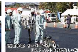
〔1〕駐車場〕オーバーレイ工法： アスファルト合材敷均し～転圧
