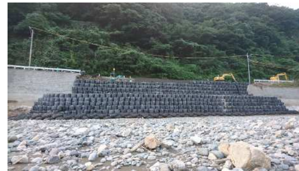
仮設工 (大型土のう設置)
