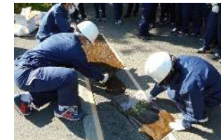
▲ 段差補修・摺付補修工法 (ロメンパッチ)
